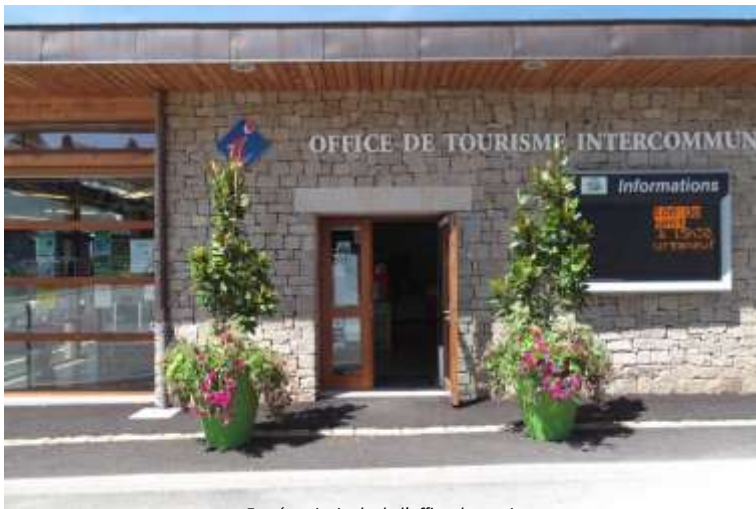
Entrée principale de l'office de tourisme
